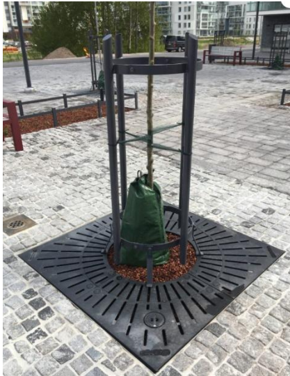
Kuva: Ilmastuskaivojen asennuspaikat maaritilän ympärillä.
