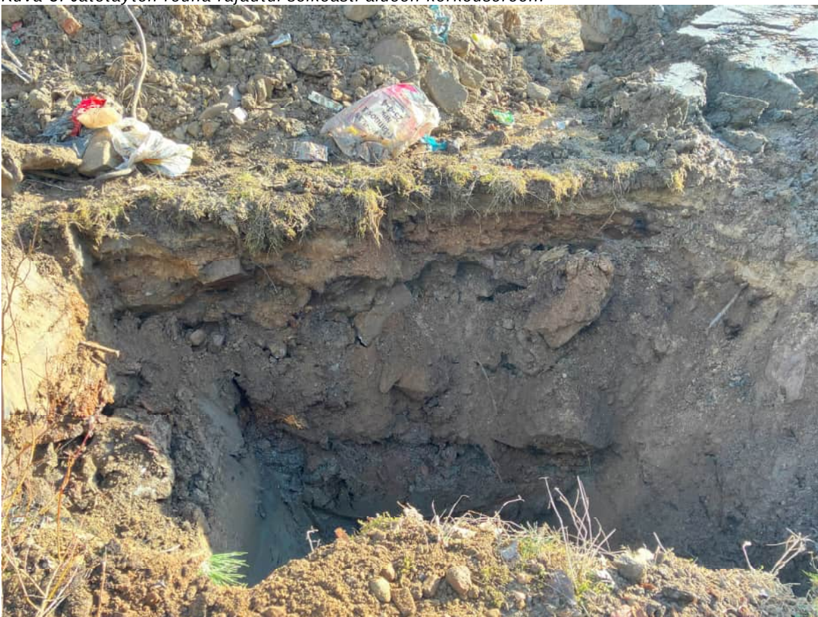
Kuva 4. Jätetäytön laajuutta selvitettiin koekuoppatutkimuksilla. Koekuoppatutkimuksen koekuoppakortit on esitetty erillisessä liitteessä.
