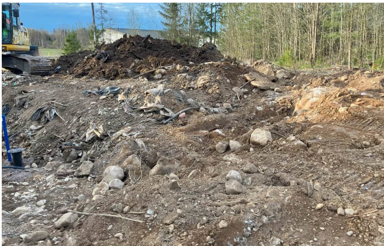
Kuva 11. Koekuopan KK4-KK6 alueen kaivua.
