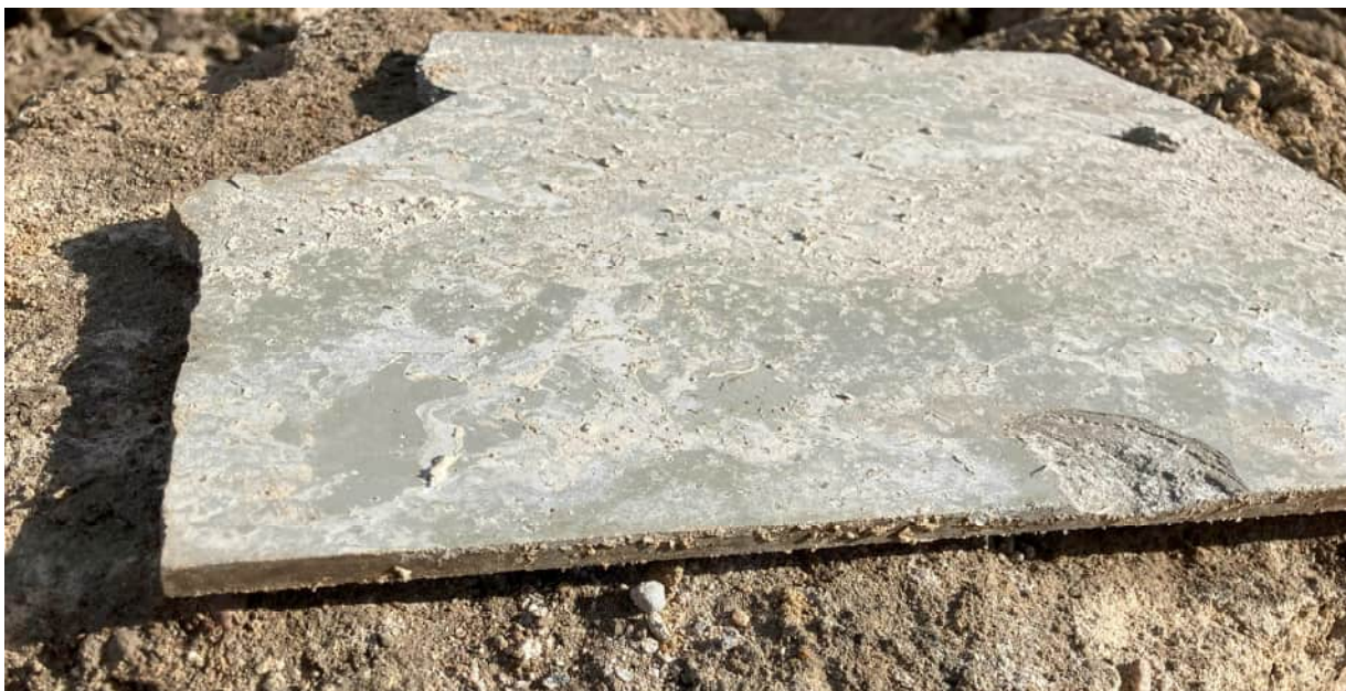
Kuva 5. Jätteen seassa havaittiin yksittäisiä asbestilevynpalasia. Asbestilevyä oli selkeästi omalla kasallaan alueen länsireunalla, jotka poistettiin asbestipurkutyönä AVI:n ohjeistuksen mukaisesti.
