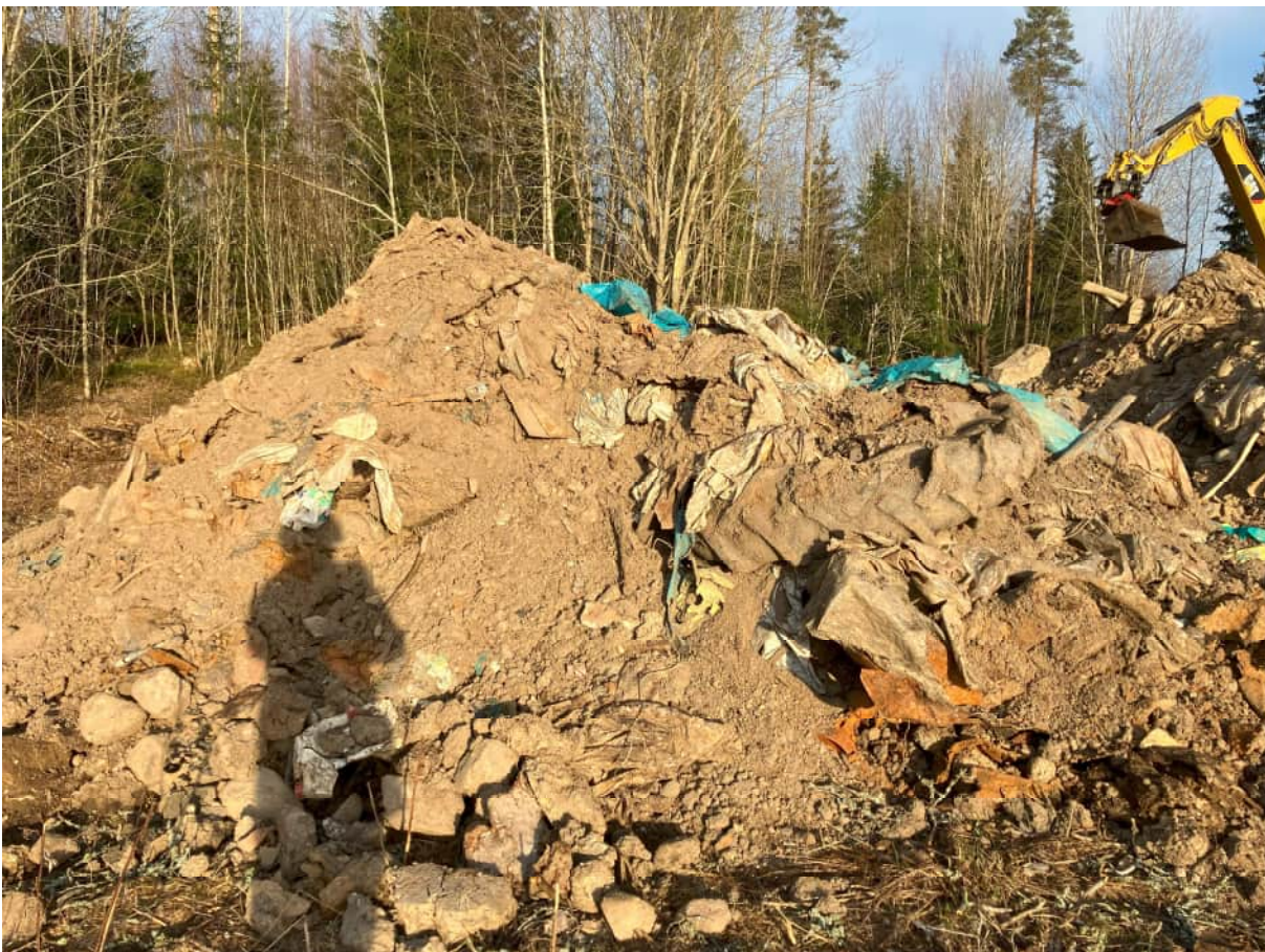
Kuva 2. Kasalle uuden tien kohdalta kaivettu jätteensekainen maa-aines.
