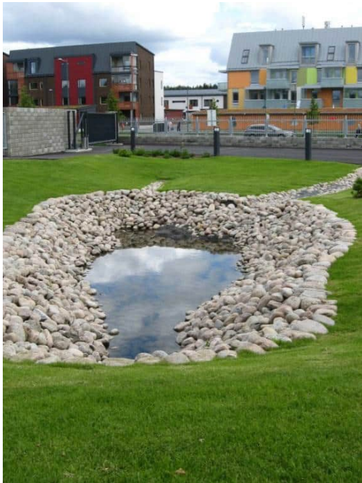
Kuva 4 a. Hulevesien viivytysallas piha-alueella, lastaus- ja paikoitusalue. b. Hulevesien viivytyspainanne piha-alueella, kerrostalo.
