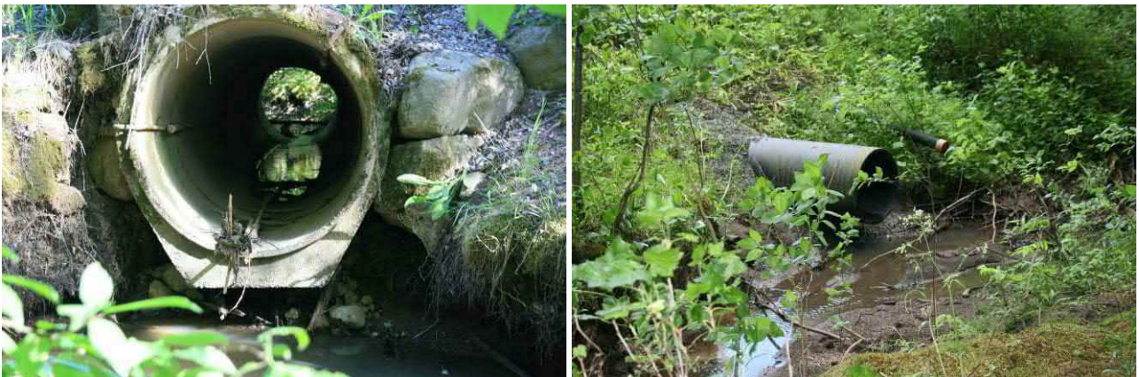
Kuva 49 a. Pyydyskorventien alittava rumpu on syöpinyt ja pidättää ylävirran puolella sedimenttiä. b. Uoman yläosalle johdetaan hulevesiä.
