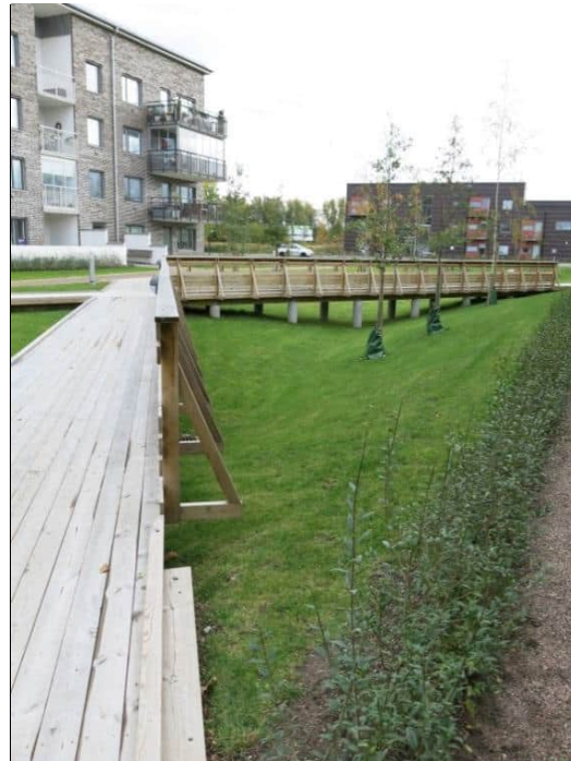
Kuva 4 a. Hulevesien viivytysallas piha-alueella, lastaus- ja paikoitusalue. b. Hulevesien viivytyspainanne piha-alueella, kerrostalo.
