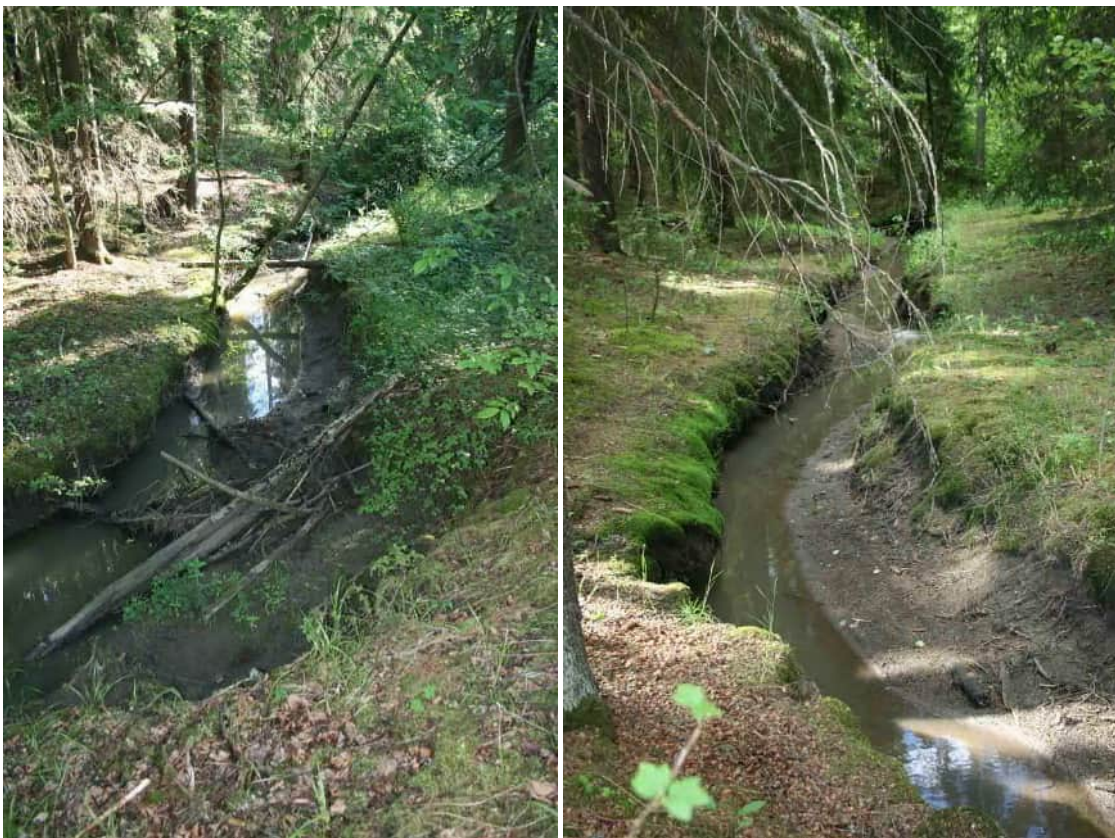
Kuva 51 a ja b. Uoman virtaus on syönyt maa-ainesta pengerten alta.
