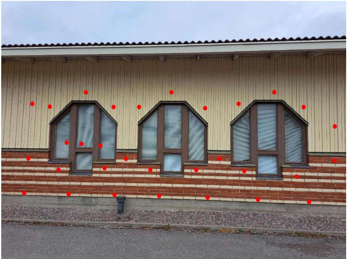
Kuva 4. Periaatekuva merkkikaasututkimuksessa poratuista kaasun syöttöreistä.
